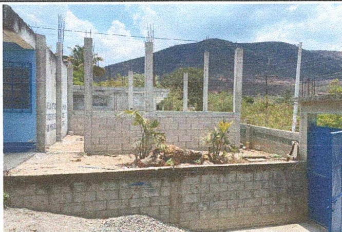
Foto 3: Cubierta de lamina
