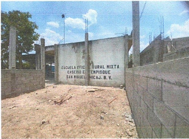
Foto1: Reparación de repello y cernido de paredes.
